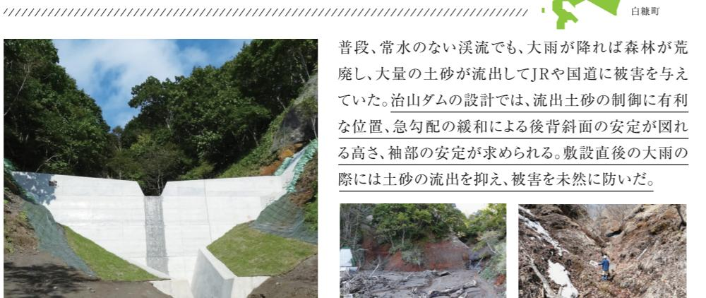
普段、常水のない渓流でも、大雨が降れば森林が荒廃し、大量の土砂が流出してJRや国道に被害を与えていた。治山ダムの設計では、流出土砂の制御に有利な位置、急勾配の緩和による後背斜面の安定が図れる高さ、袖部の安定が求められる。敷設直後の大雨の際には土砂の流出を抑え、被害を未然に防いだ。
