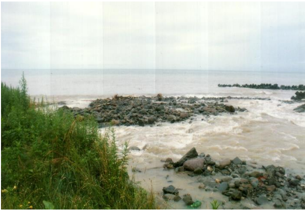
図-2 海に流出し、漁港を埋積した土石流堆。1999年7月撮影。
