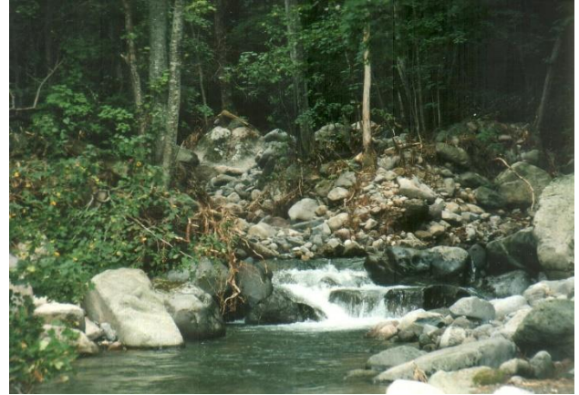
図-3 既設の床固工を埋積した土石流堆積物。1999年7月撮影。
