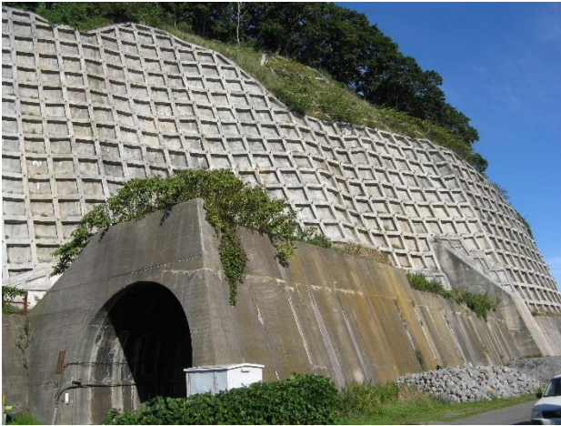
図-6 対策工完成の状況.
