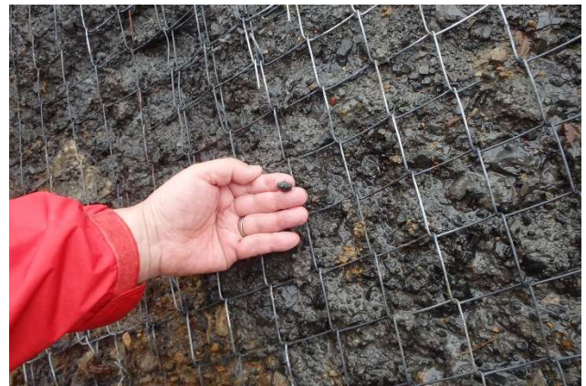
図-8 すべり層中の角礫・亜角礫（網の中）と地すべりで研磨された円礫（手の上）．図-3 の赤○箇所近接撮影．
