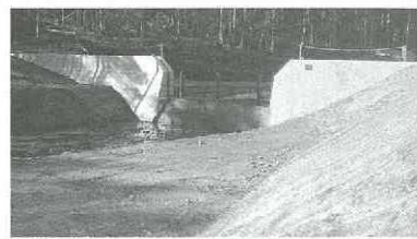
イワイ沢緊急予防治山工事 本田・坂野JV
