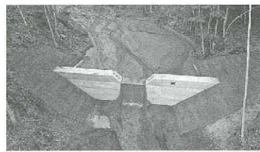
吉本地先復旧治山工事 西岡建設株式会社
